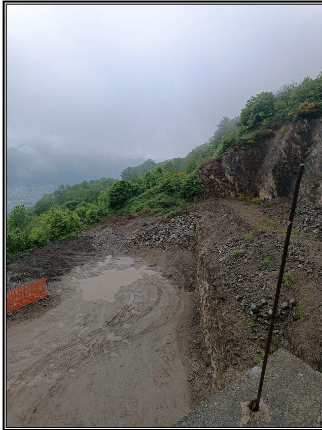
Foto 1: Vista est dell'area oggetto dei lavori
